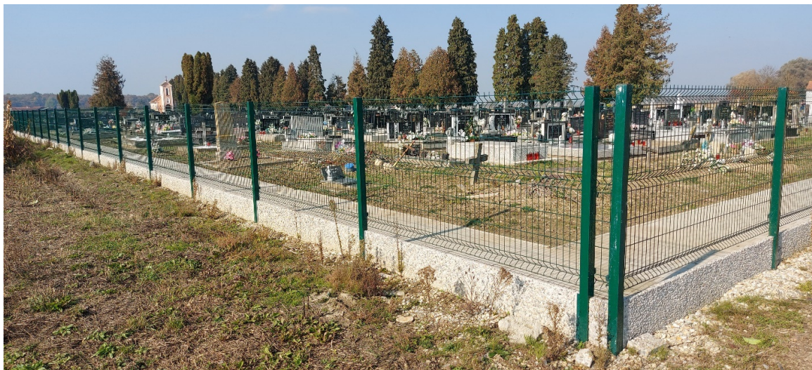
Slika 5. Nova ograda oko groblja u naselju Ferdinandovac
