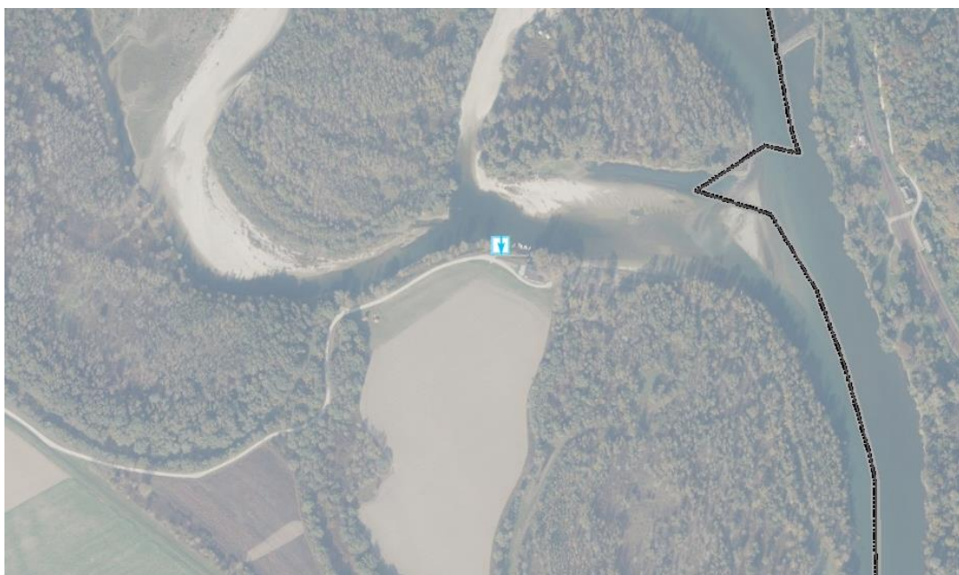
Slika 37.: Prikaz postojećeg pristaništa na području Općine Legrad
