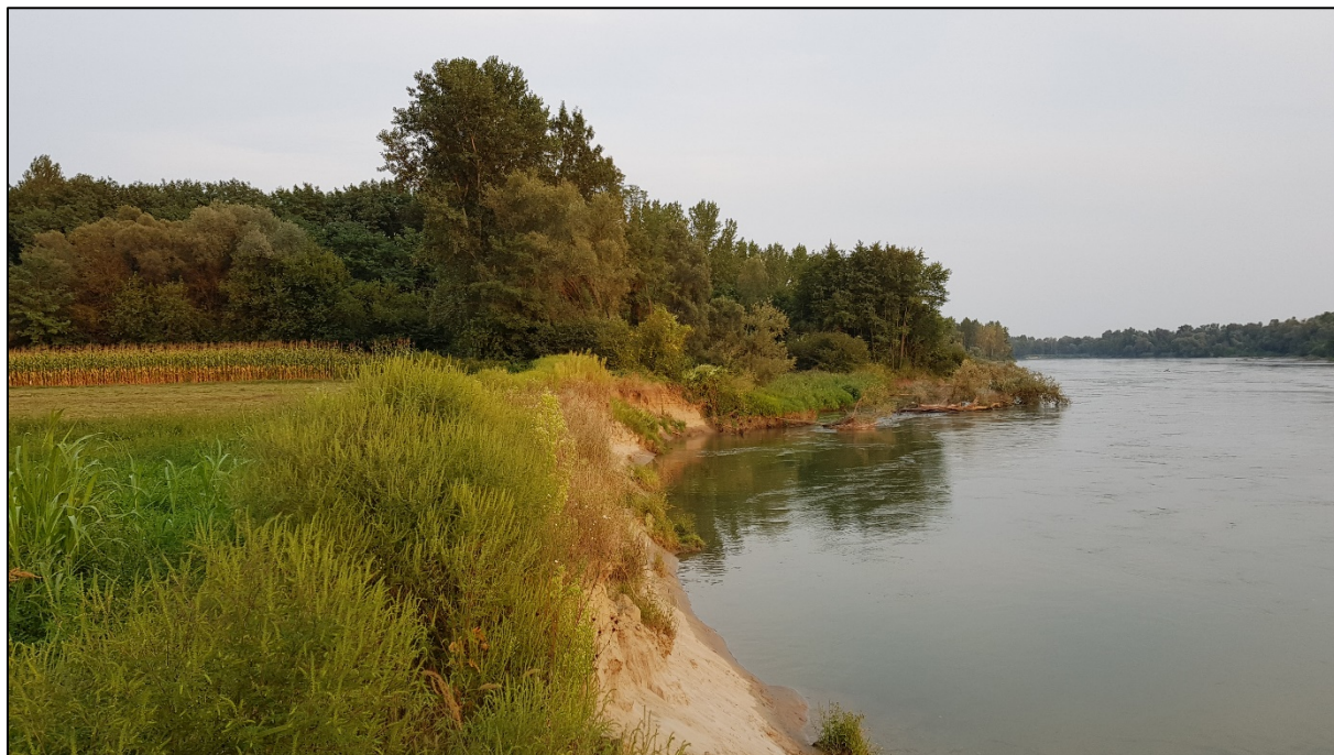
Slika 34. Pogled nizvodno na erodiranu obalu uz planiranu ukopanu deponiju
