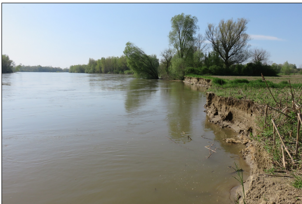
Slika 35. Pogled uvodno na erodiranu obalu uz planiranu ukopanu deponiju
