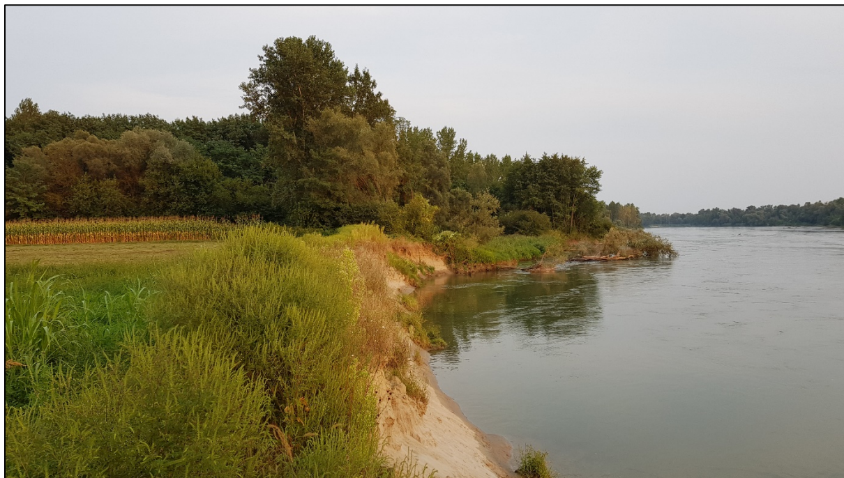
Slika 37. Pogled nizvodno na erodiranu obalu uz planiranu ukopanu deponiju
