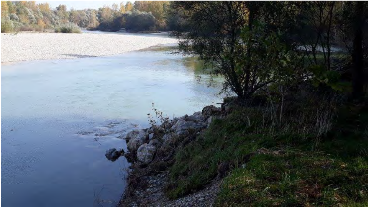
Slika 6. Lokacija 118 - regulacijska vodna građevina pero
