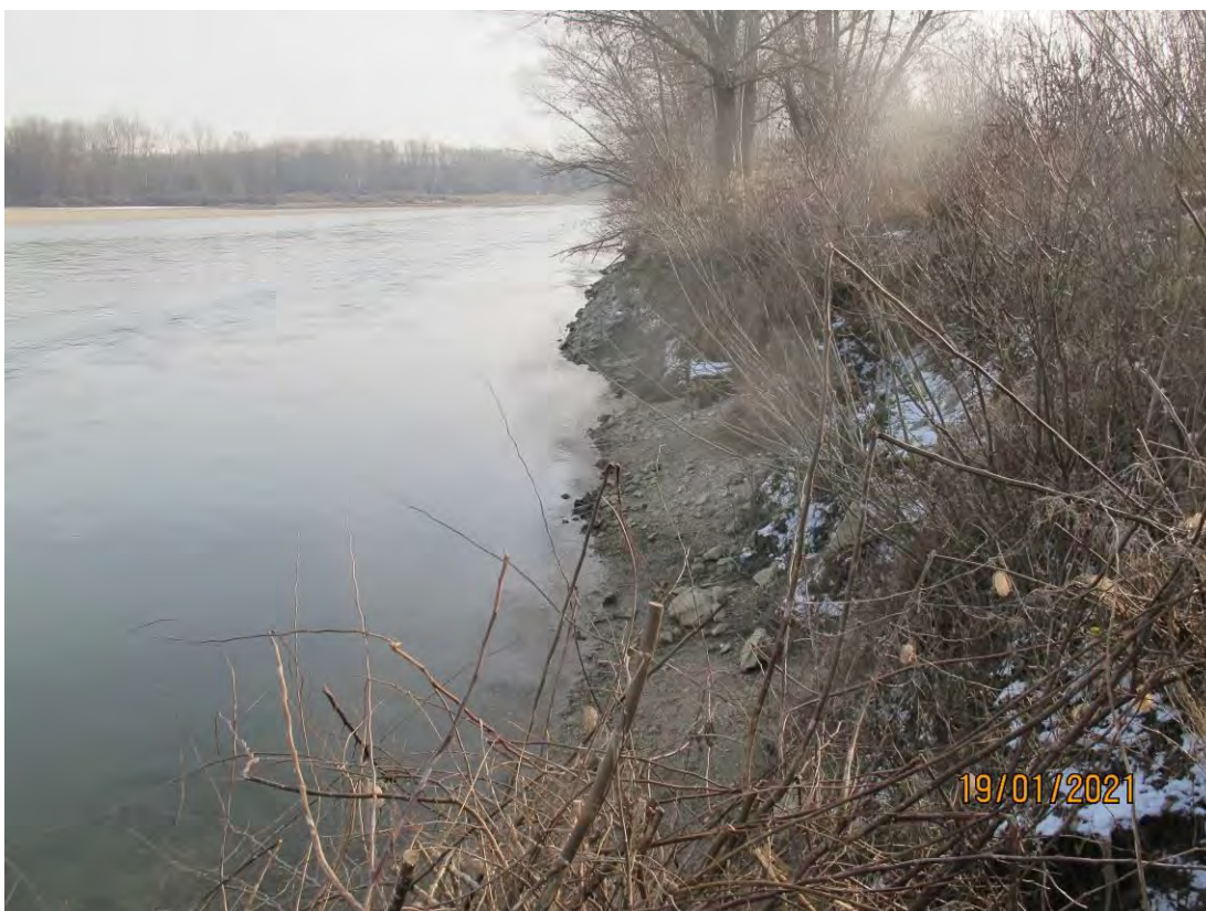
Slika 5. Lokacija 106 – pogled nizvodno (GPS točka 049)
