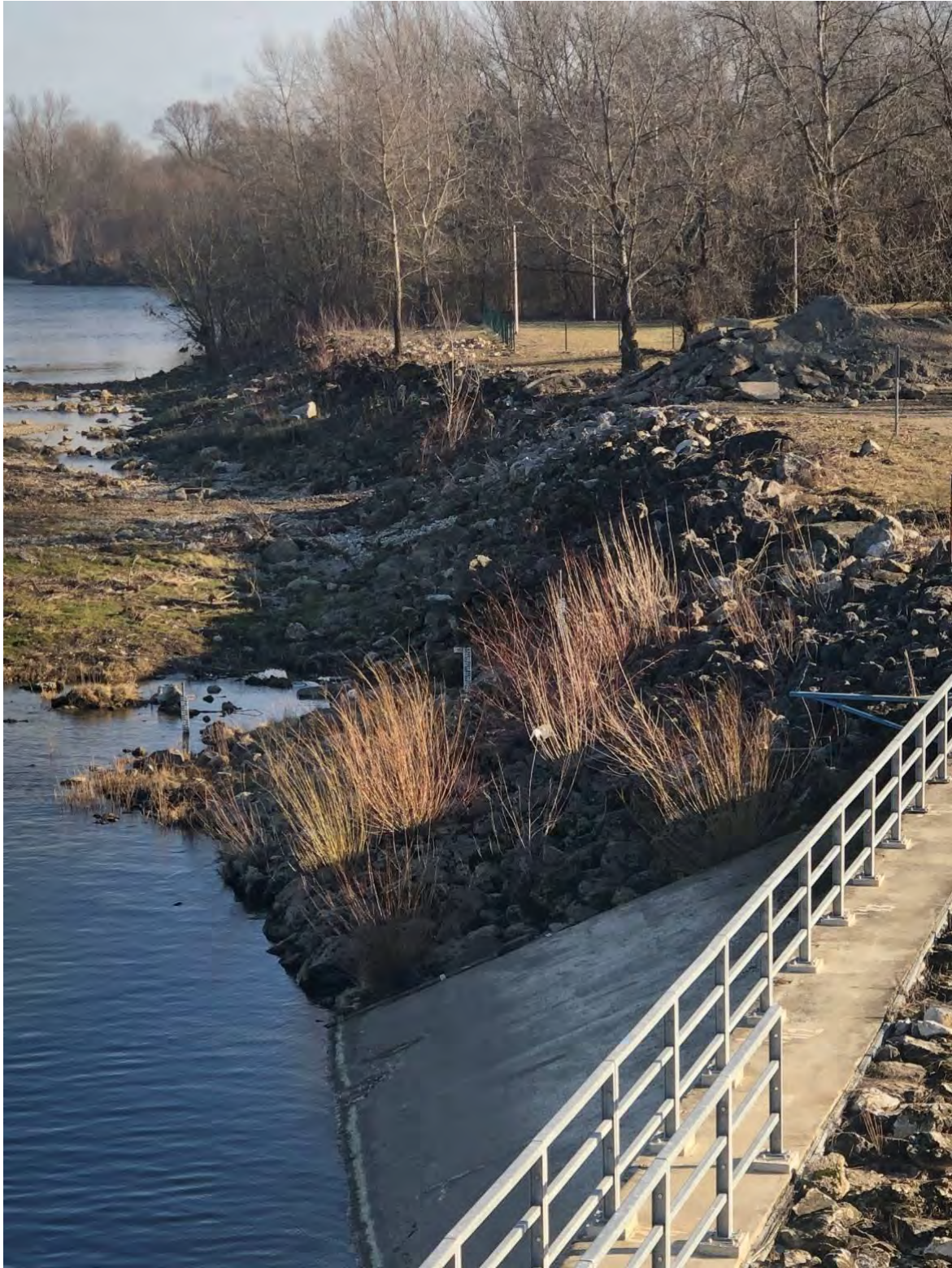
Slika 12. Lokacija 270, regulacijska vodna građevina obaloutvrda
