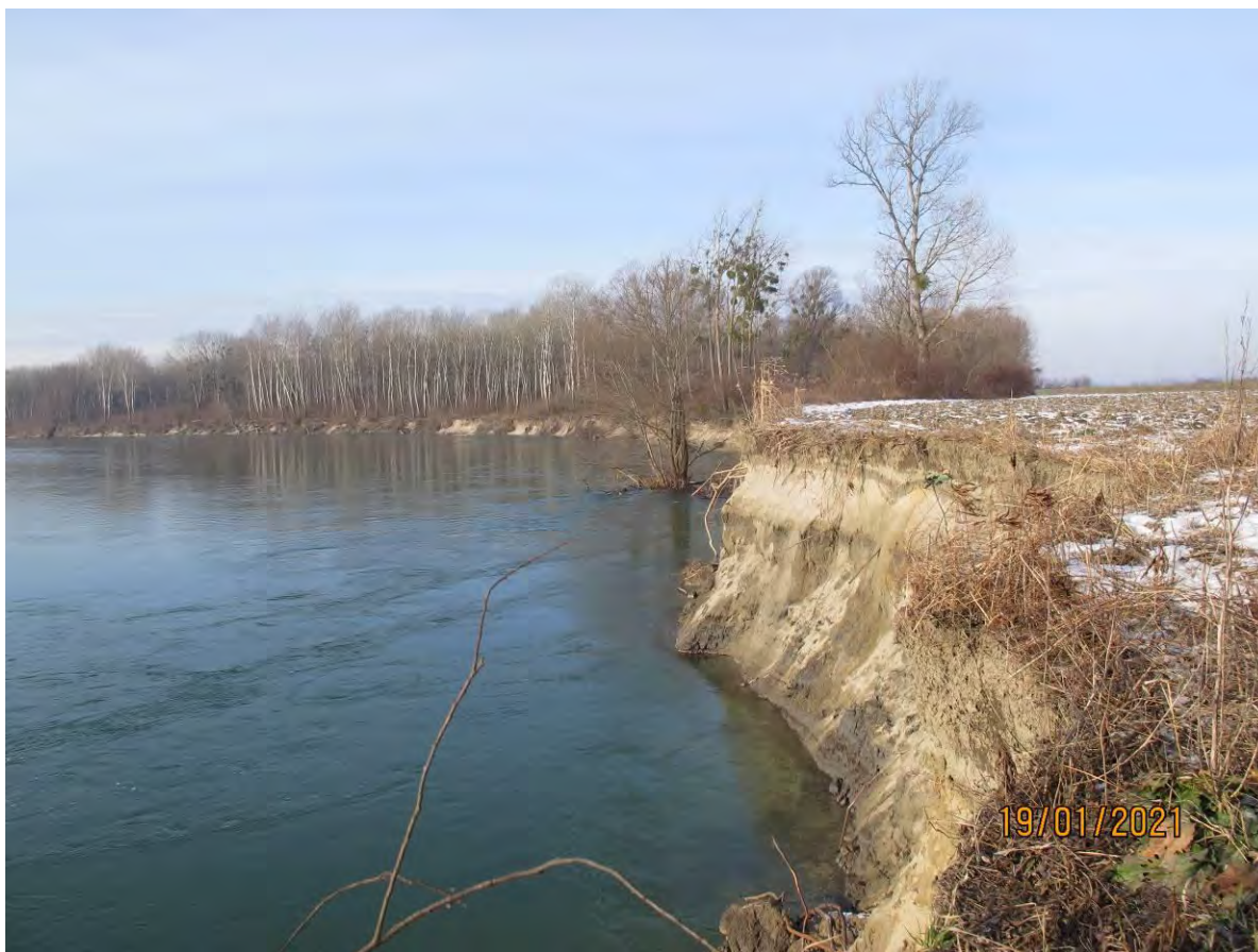
Slika 1. Lokacija 107 – početak planiranog popravka, pogled uzvodno (GPS točke 047 i 048)
