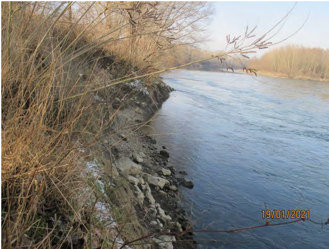
Slika 4. Lokacija 106 – pogled uzvodno (GPS točka 050)
