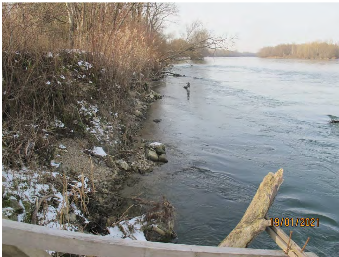
Slika 11. Lokacija 203 (GPS točka 054) – pogled uzvodno
