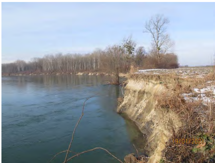
Slika 1.1.1.5. Lokacija 107 početak planiranog popravka, pogled uzvodno (GPS točke 047 i 048)
