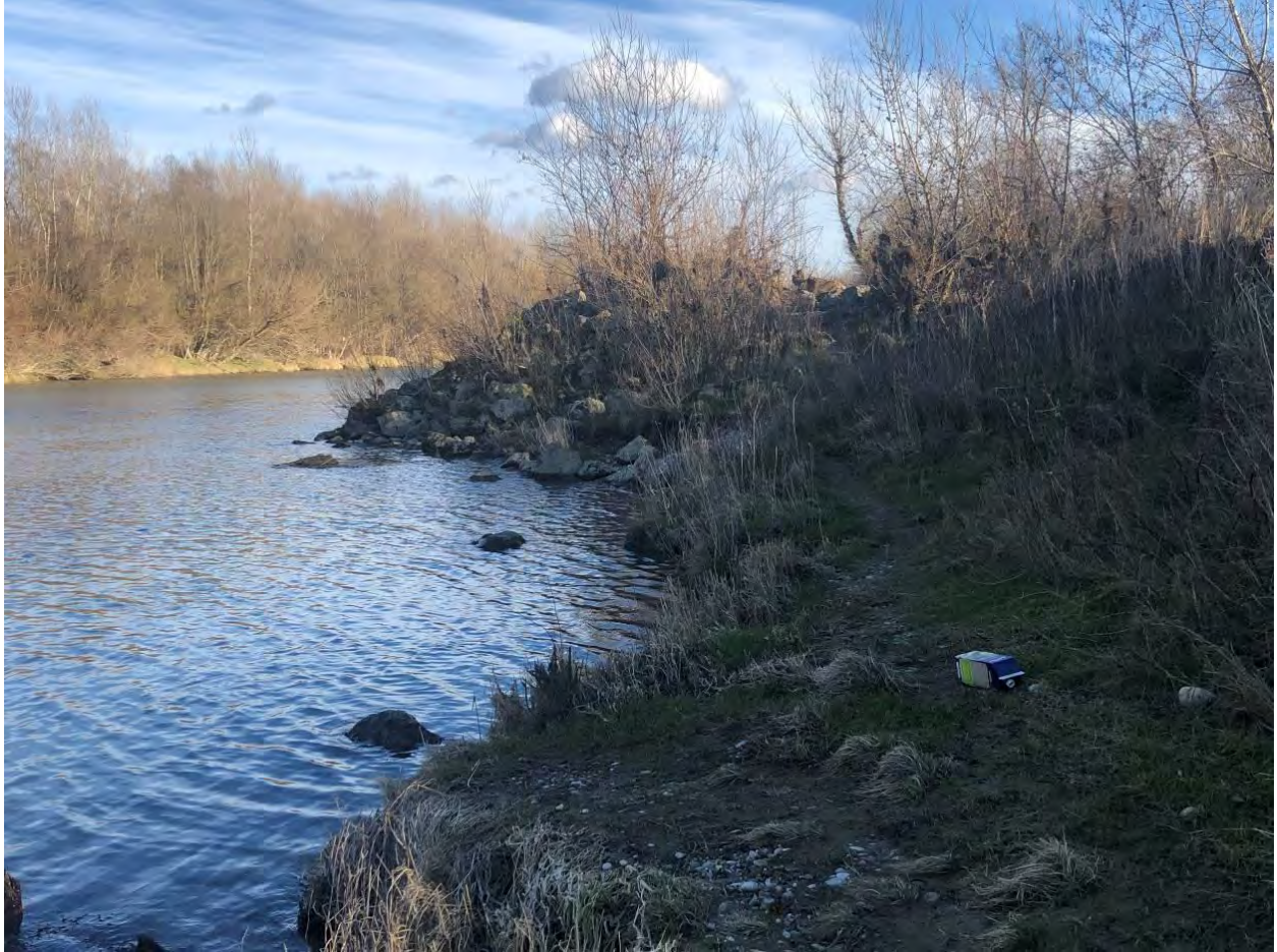
Slika 2. Lokacija 277, regulacijska vodna građevina pero
