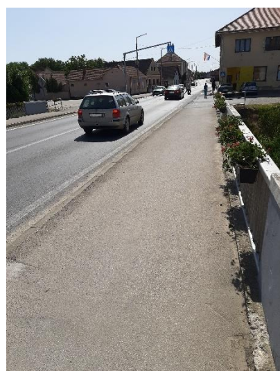
Most DC2 preko Komarnice u naselju Novigrad Podravski
