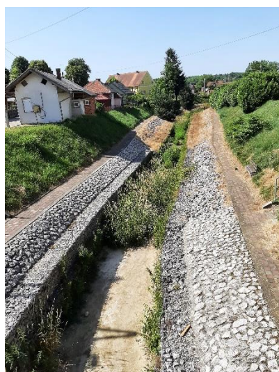
Uređeni dio Komarnice južno od mosta DC2 u Novigradu Podravskom
