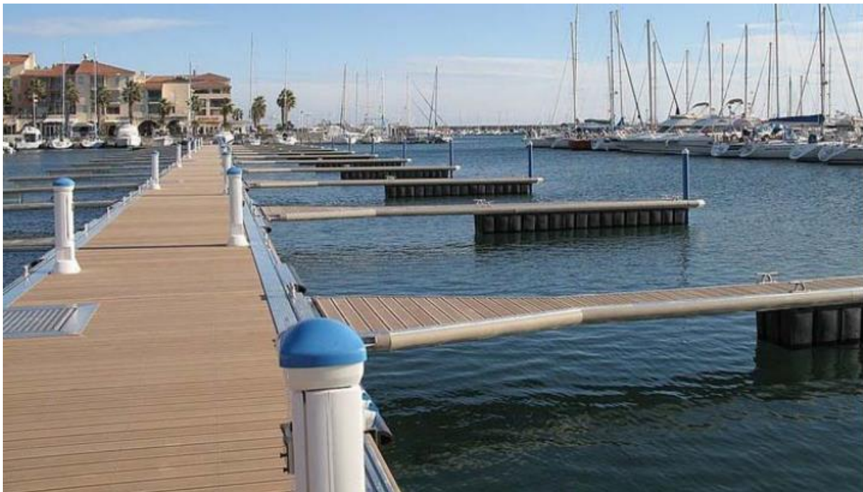
Slika 2-7 Primjer sustava pričvršćenja brodica pomoću fingera (preuzeto iz HIDROING 2019)
