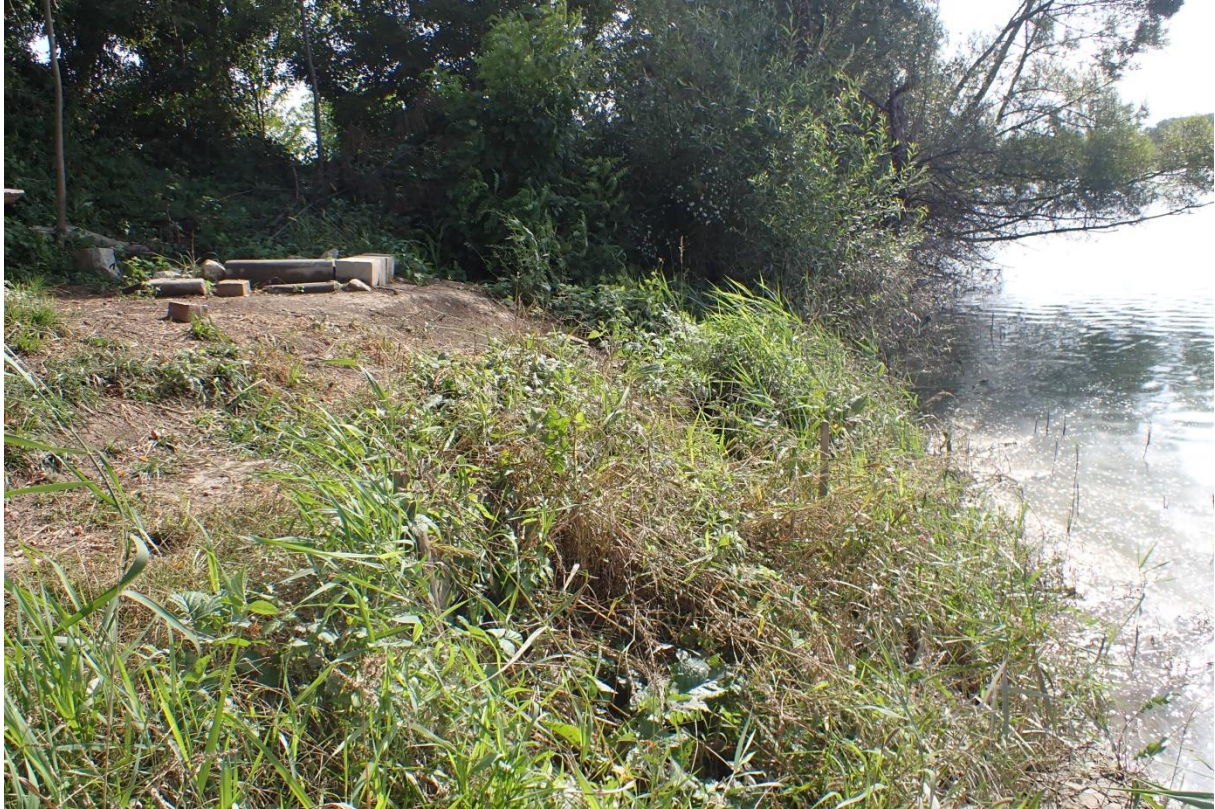
Slika 2-2 Zateknuto stanje uz obalu Drave na sjevernom dijelu obuhvata zahvata s ribičkim punktom i drvenim kolčićem za privez čamaca (rujan 2020; autor: Geonatura d.o.o.)
