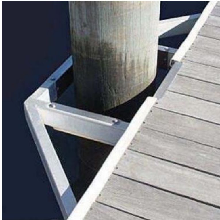
Slika 2-5 Fiksiranje pontonskog gata pilotom (preuzeto iz HIDROING 2019)
