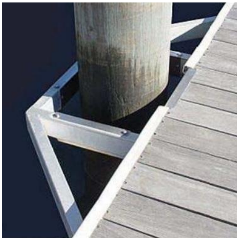
Slika 2-5 Fiksiranje pontonskog gata pilotom (preuzeto iz HIDROING 2019)
