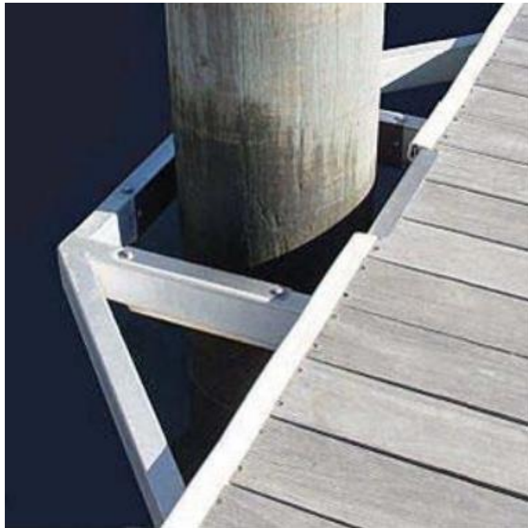
Slika 2-5 Fiksiranje pontonskog gata pilotom (preuzeto iz HIDROING 2019)
