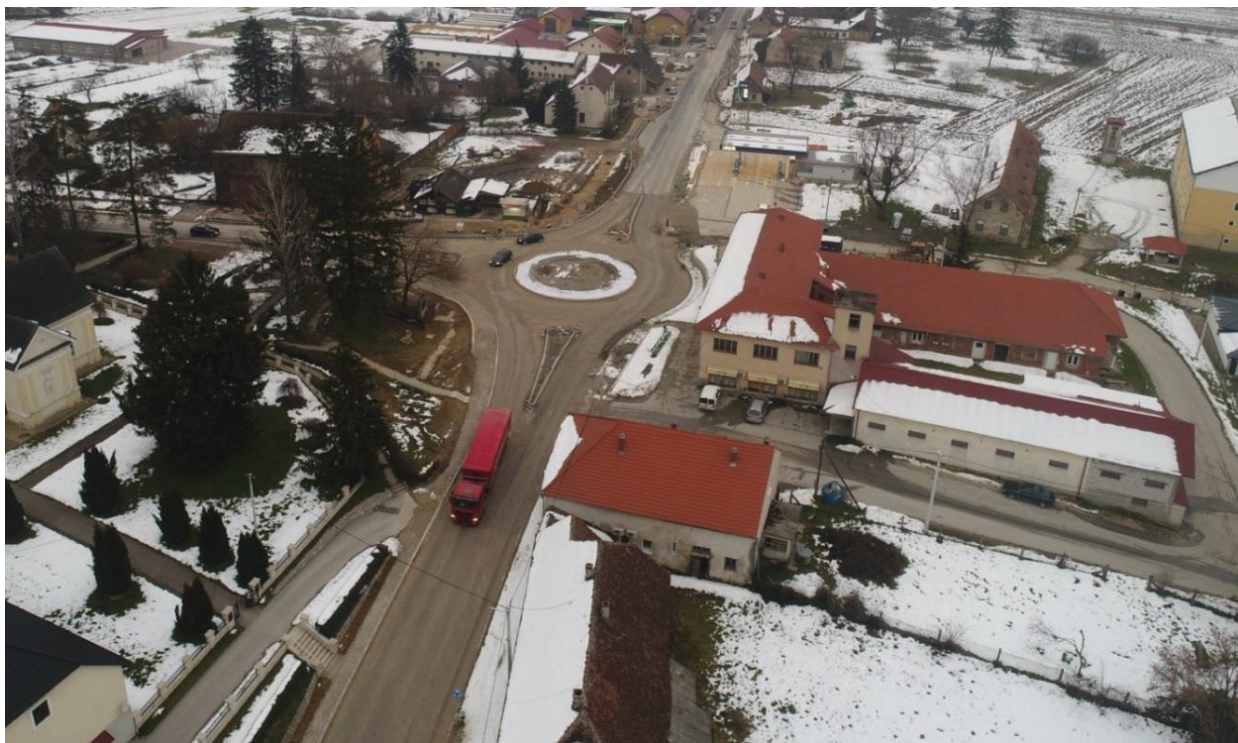
Slika 8. Izgradnja kružnog toka i rekonstrukcija pristupnih prometnica u centru naselja Sveti Ivan Žabno
