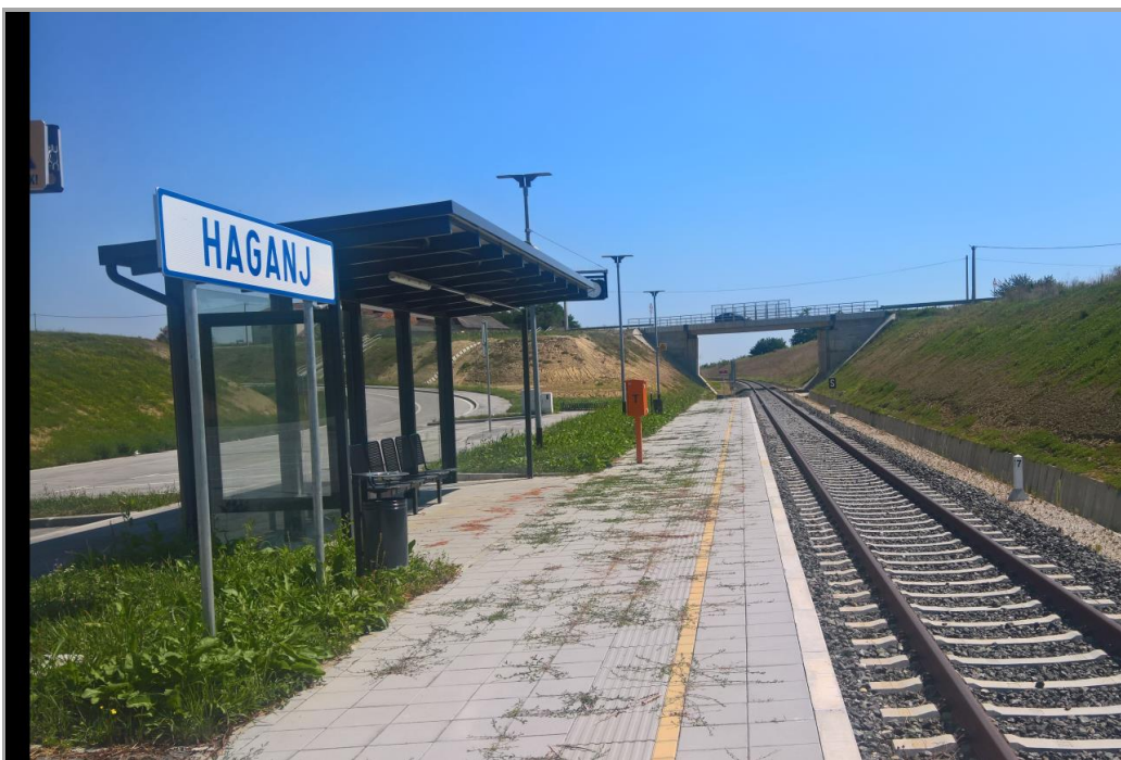
Slika 9. Novoizgrađena željeznička pruga L 214 -Gradec
