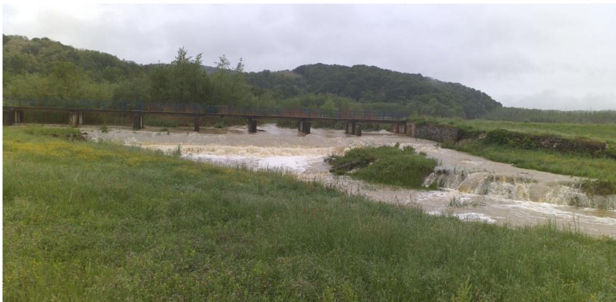
Fotografija 3-8: Aktivacija bočnog preljeva
