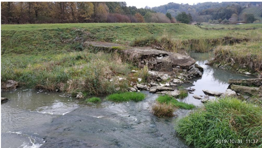
Fotografija 3-9: Kaskada na preljevnom kanalu
