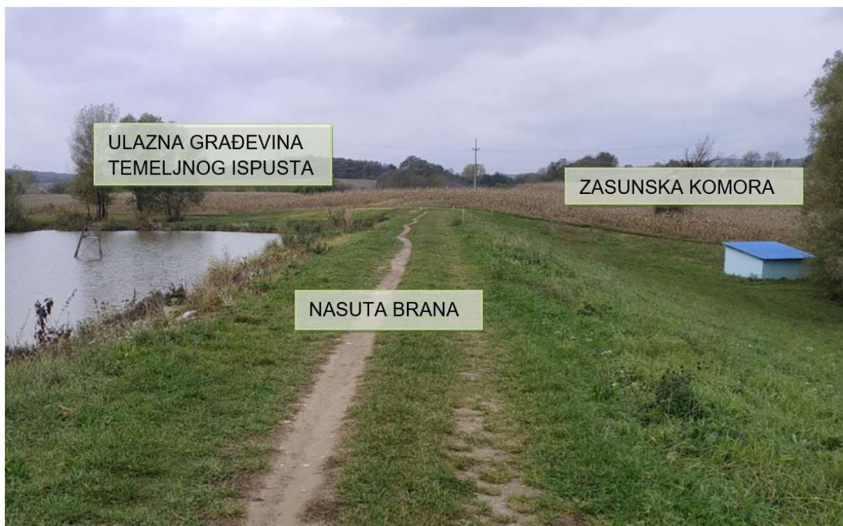
Fotografija 3-4: Uzdužni pogled na temeljni ispust
