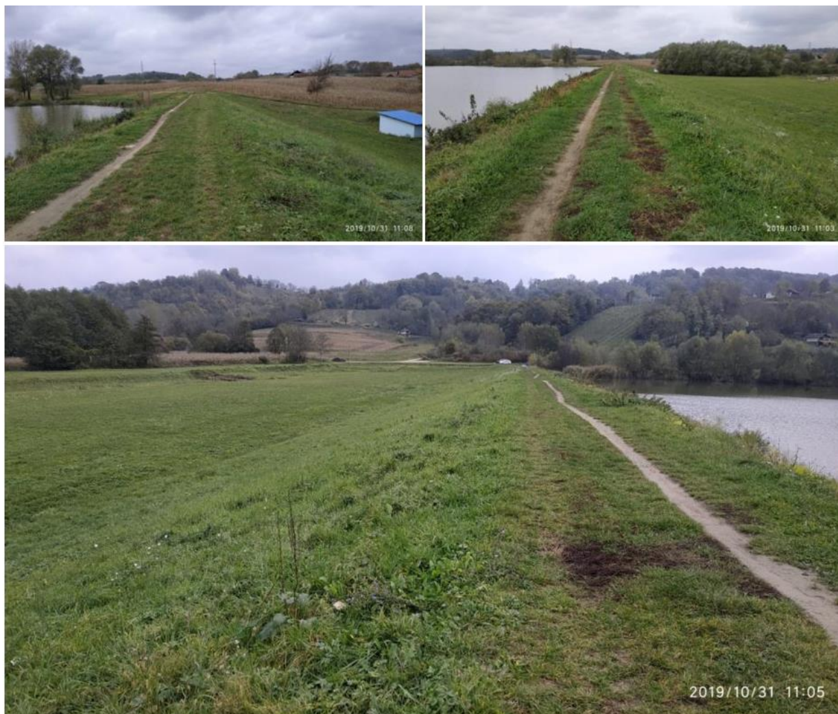
Fotografija 3-2: Brana akumulacije (gore – pogled prema rampi, dolje – pogled prema bočnom preljevu)
