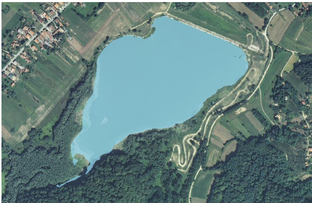
Grafički prikaz 3-9: Doseg vode za uobičajenu razinu vode u akumulaciji (H=158.2 m n. m.)
