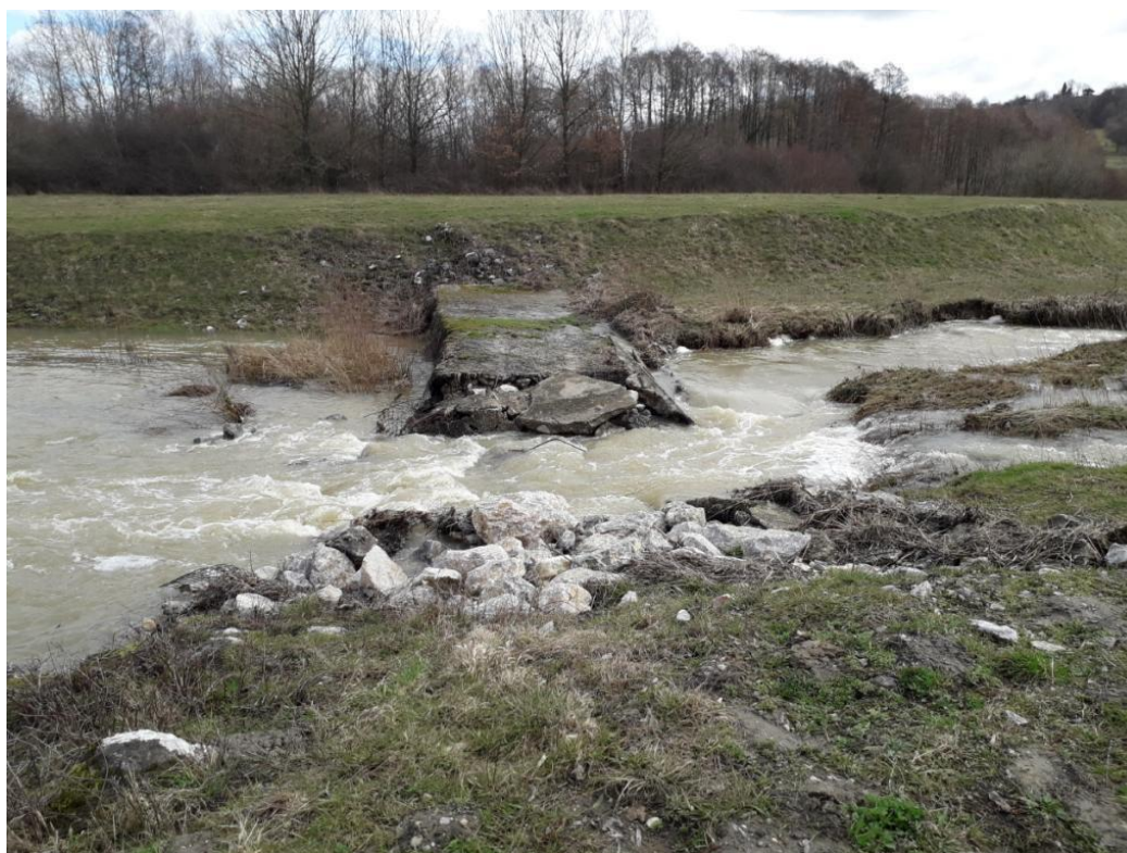
Fotografija 3-10: Aktivacija bočnog preljeva - preljevni kanal
