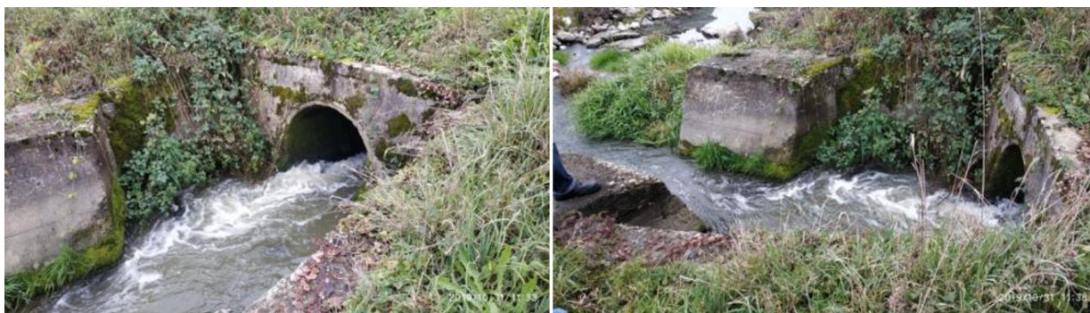
Fotografija 3-6: Ušće temeljnog ispusta u odvodnom kanalu
