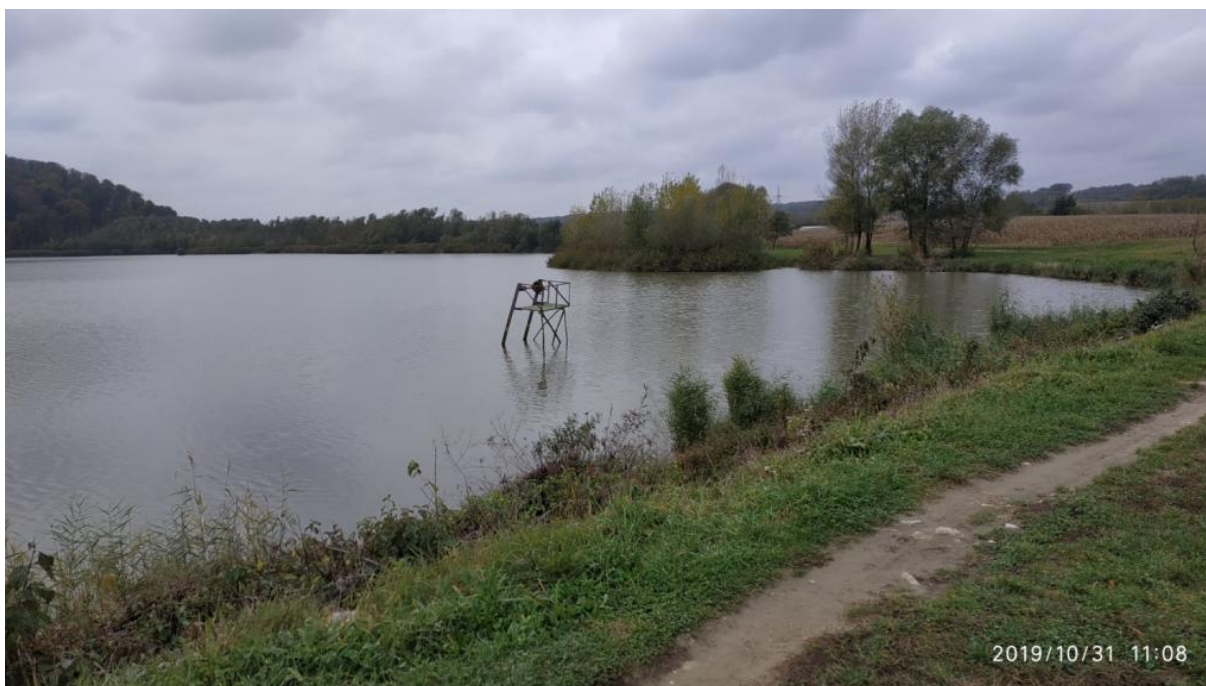
Fotografija 3-3: Ulazna građevina temeljnog ispusta
