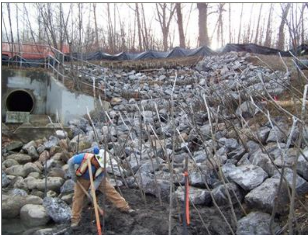
Slika 34. Lokacija zahvata tijekom izvođenja radova (preuzeto iz Lončar, G. i sur., 2017)
