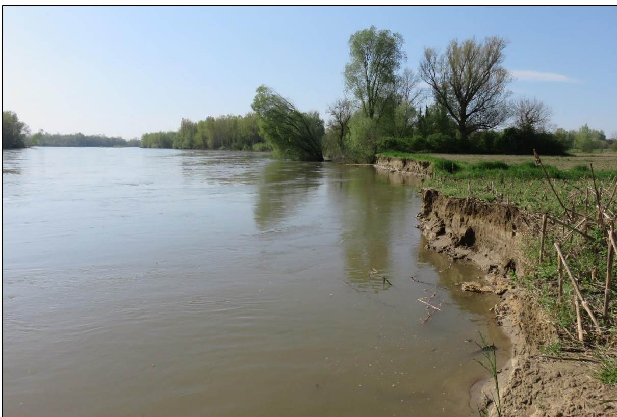
Slika 22. Pogled na uzvodni dio planirane obaloutvrde
