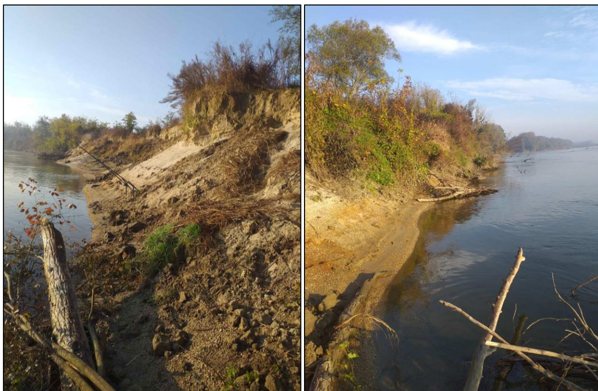
Slika 43. Lokacija pera br. 1. – lijevo (pogled nizvodno), desno (pogled uzvodno)
