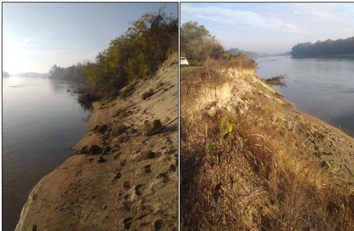
Slika 44. Lokacija pera br. 2. – lijevo (pogled nizvodno), desno (pogled uzvodno)
