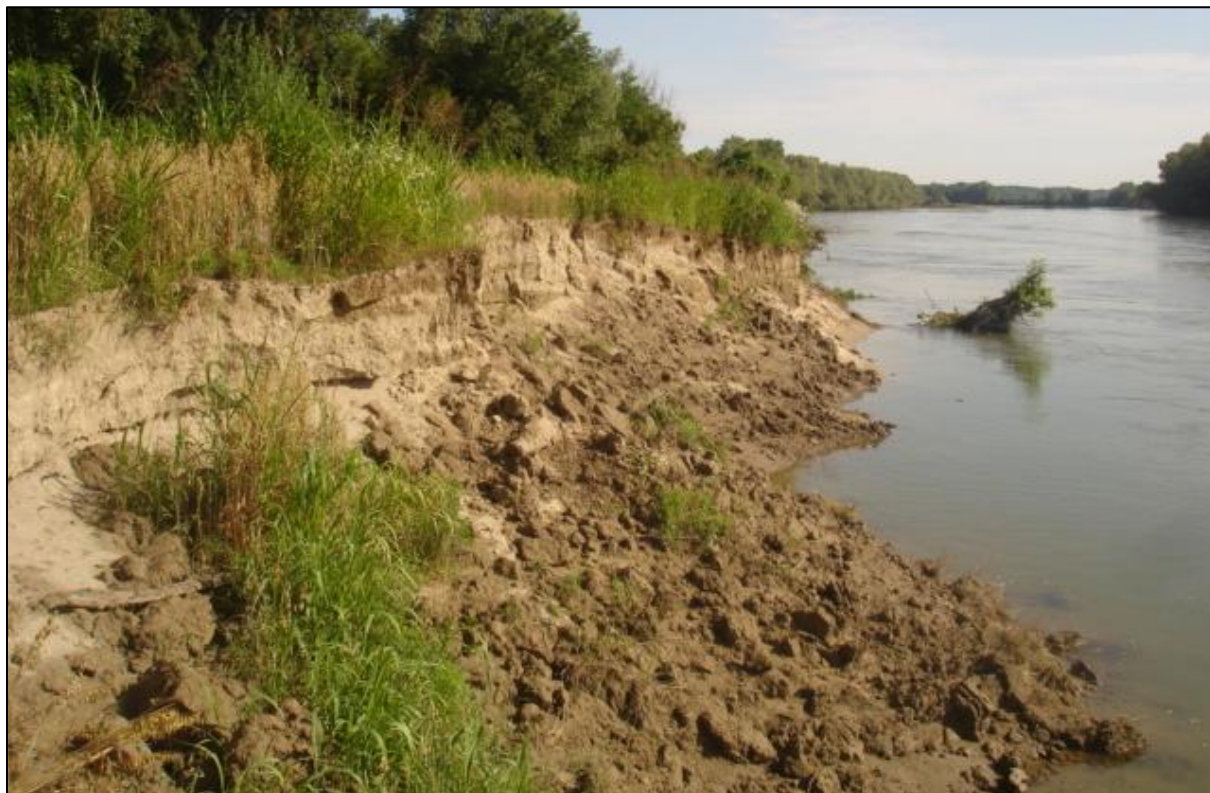
Slika 42. Erodirana obala bez drvenaste vegetacije na lokaciji izgradnje pera br. 1
