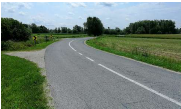
Slika 1.1.3.4. Smjer R. Mađarska - Botovo (km14+350) - oštar zavoj na napuštenom dijelu trase
