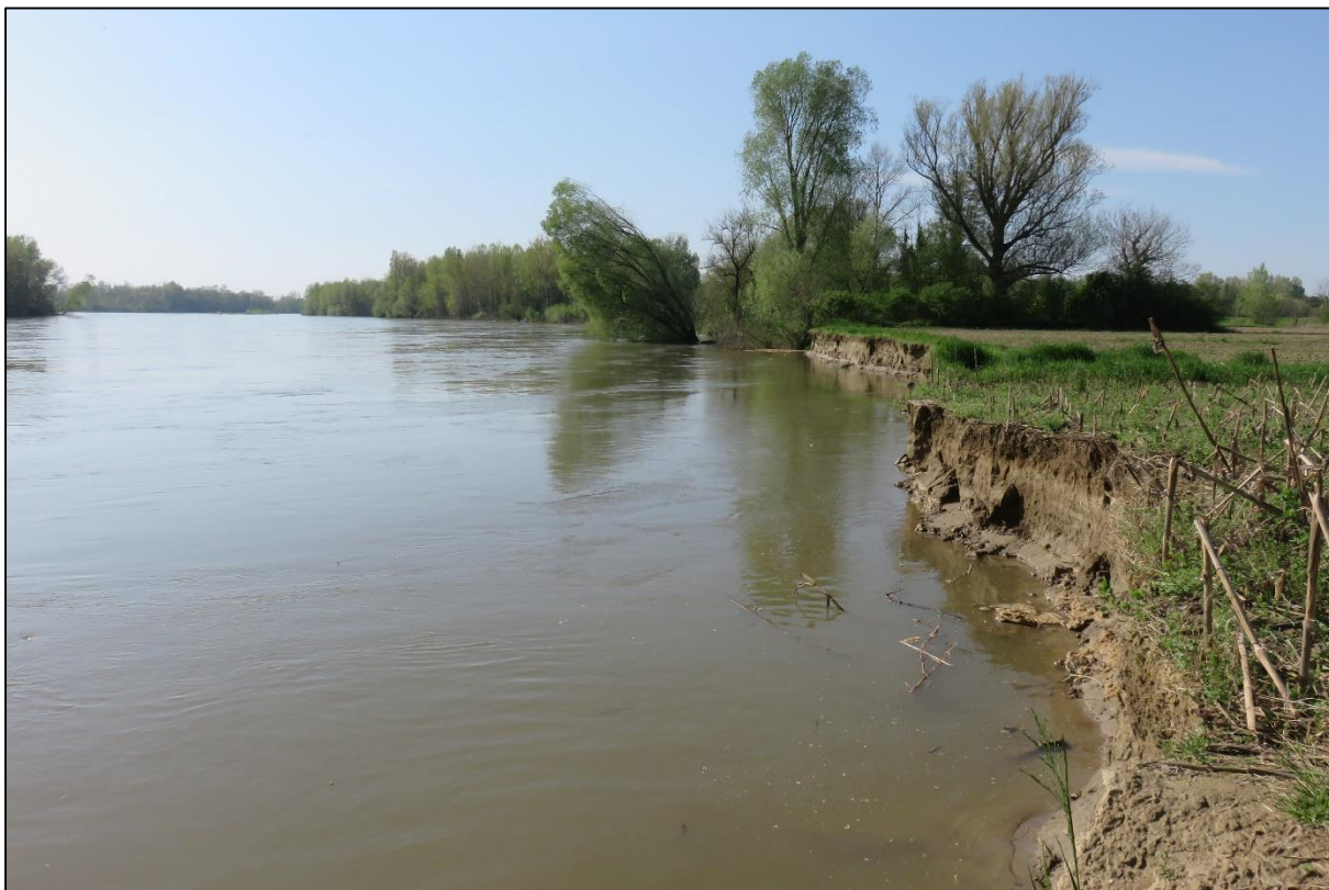
Slika 19. Pogled na uzvodni dio planirane obaloutvrde
