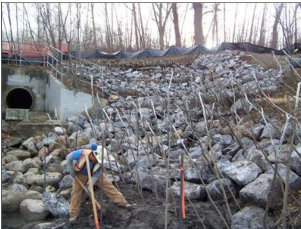
Slika 31. Lokacija zahvata tijekom izvođenja radova (preuzeto iz Lončar, G. i sur., 2017)
