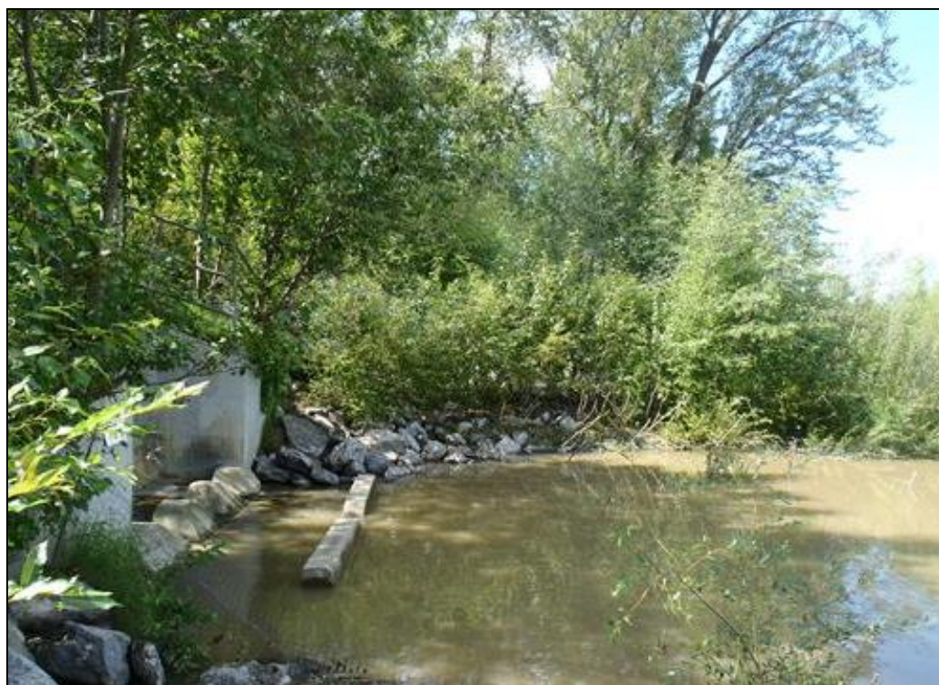
Slika 32. Lokacija zahvata 4. godine nakon izvođenja radova (preuzeto iz Lončar, G. i sur., 2017)
