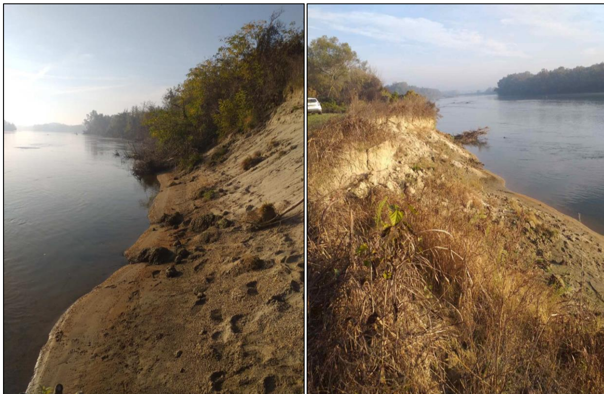
Slika 40. Lokacija pera br. 2. – lijevo (pogled nizvodno), desno (pogled uzvodno)
