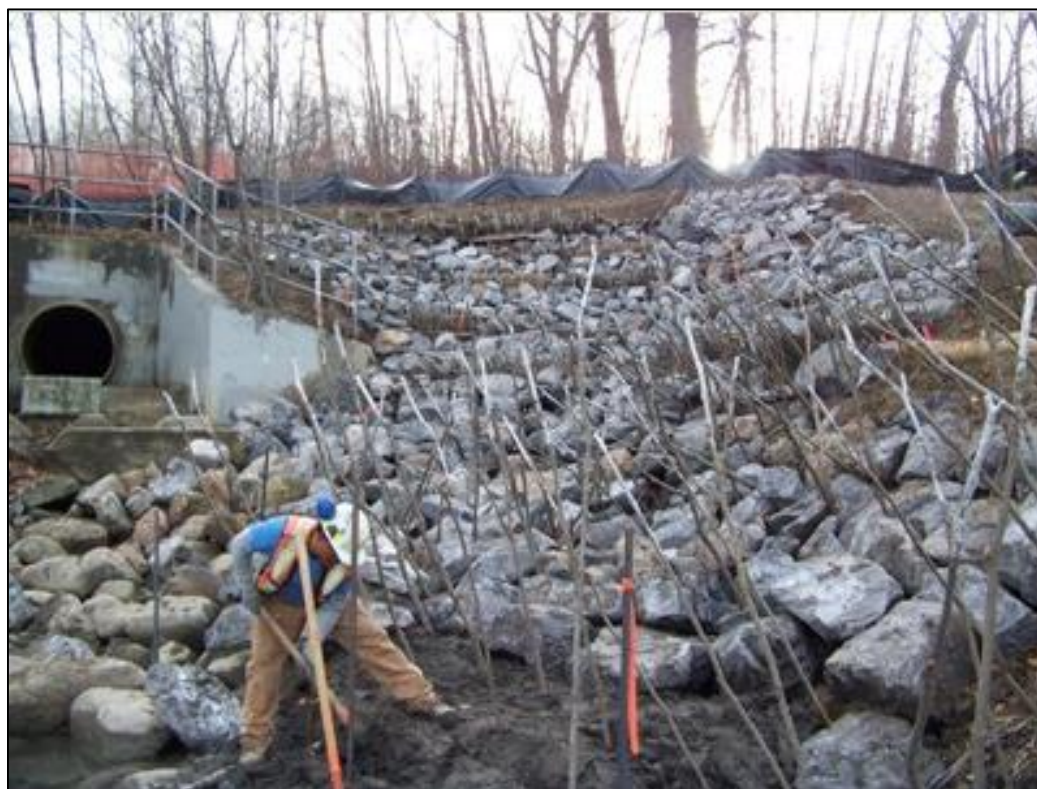
Slika 50. Lokacija zahvata tijekom izvođenja radova (preuzeto iz Lončar, G. i sur., 2017)
