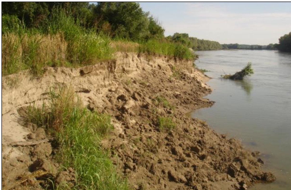
Slika 38. Erodirana obala bez drvenaste vegetacije na lokaciji izgradnje pera br. 1
