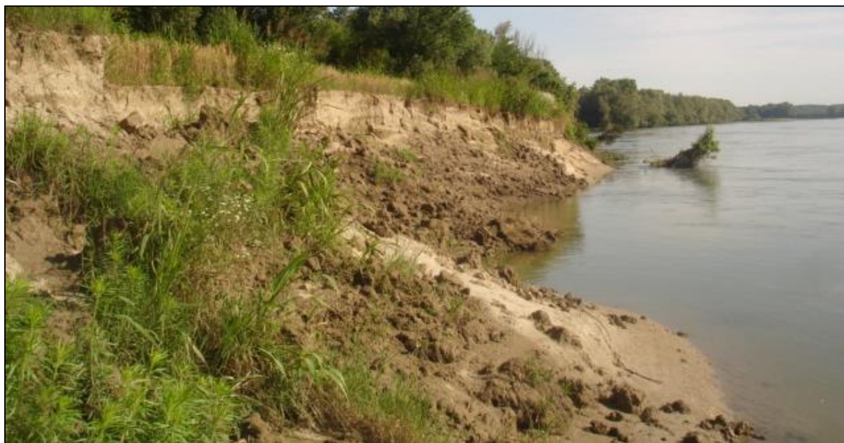
Slika 11. Erodirana obala oko 700 m uzvodno od skele Brodić
