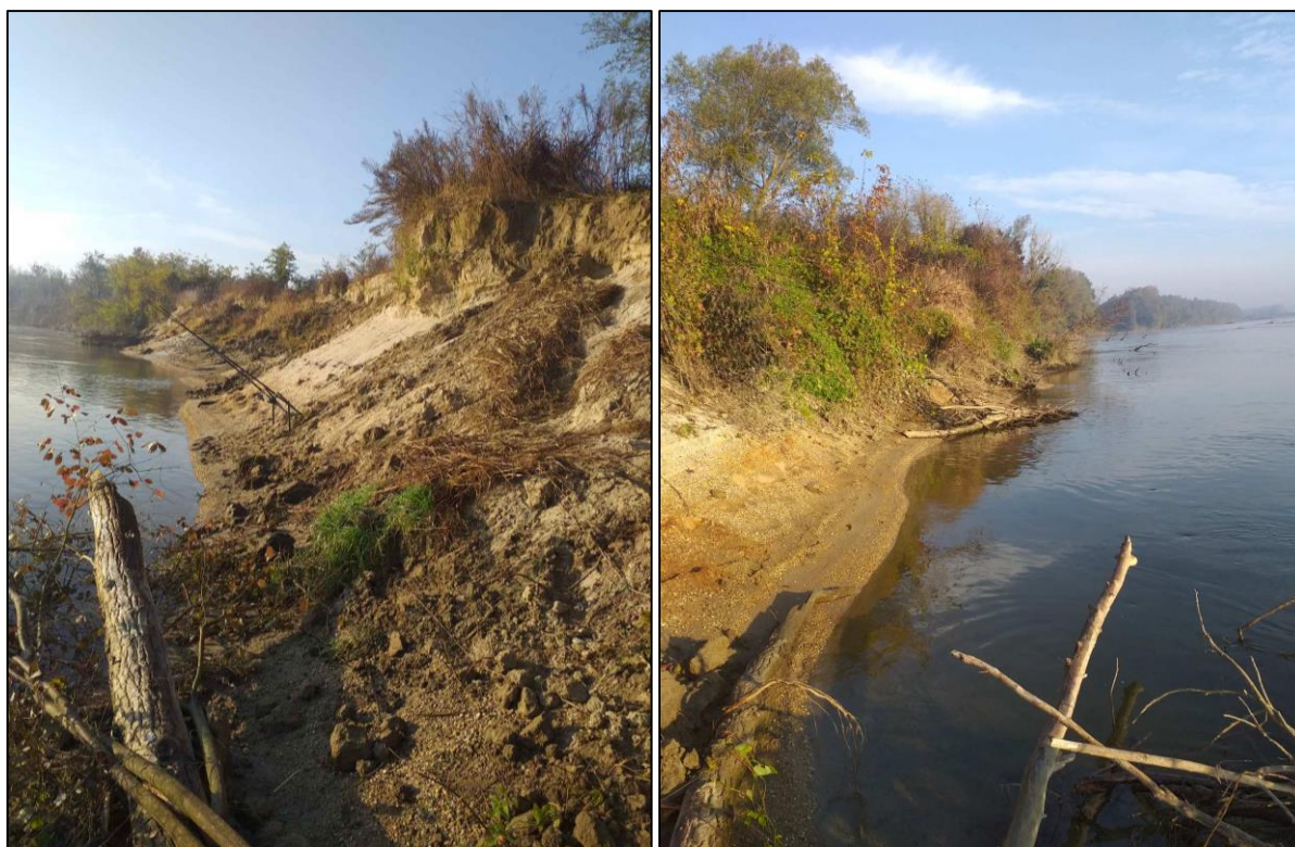
Slika 39. Lokacija pera br. 1. – lijevo (pogled nizvodno), desno (pogled uzvodno)
