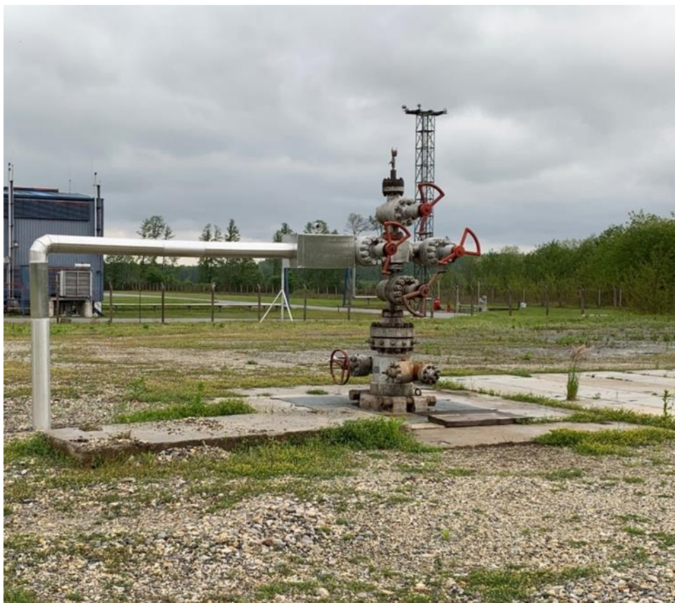
Fotografija C-1: Tipična nadzemna oprema bušotine za utiskivanje slojne vode
