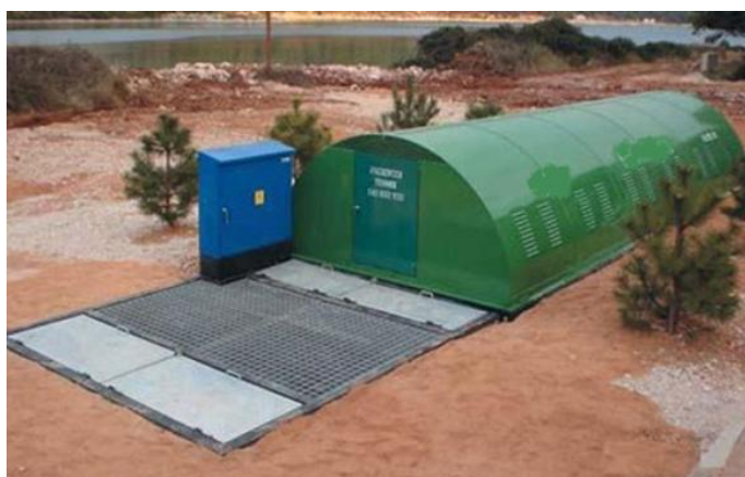
Slika 2.7. Primjer ugrađenog tipskog uređaja za pročišćavanje otpadnih voda
