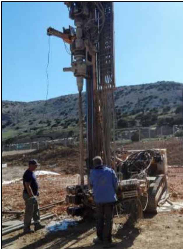
Slika 2.2-1. Primjer provođenja istražnih radova tj. bušenje istražne bušotine
