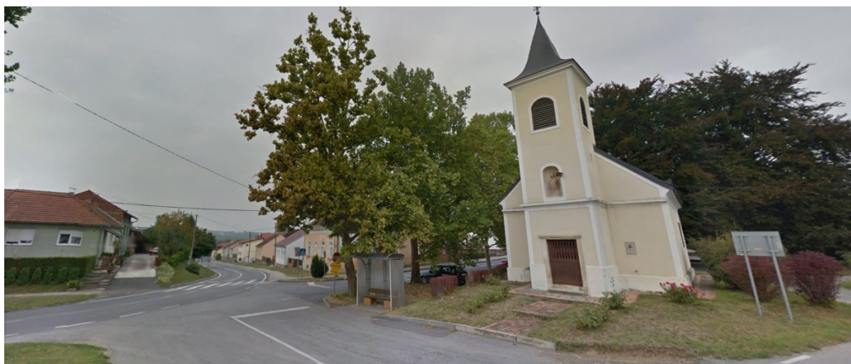
Slika 3.2.10-1. Prikaz predmetne prometnice na završetku trase i Kapela Sv. Roka predviđena za zaštitu, izvor: Google maps
