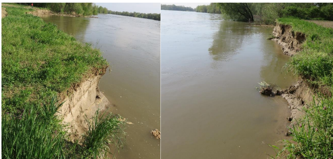
Slika 34. Lokacija zahvata (travanj, 2018.)
