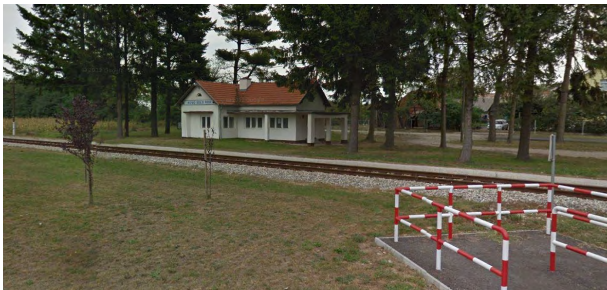
Slika 16.39. Željezničko stajalište Novo Selo Rok Izvor: Google maps
