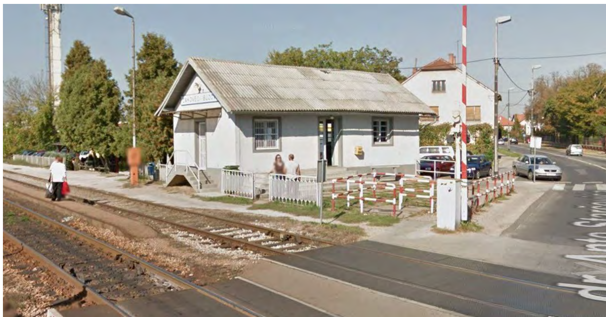
Slika 16.38. Željezničko stajalište Čakovec – Buzovec Izvor: Google maps
