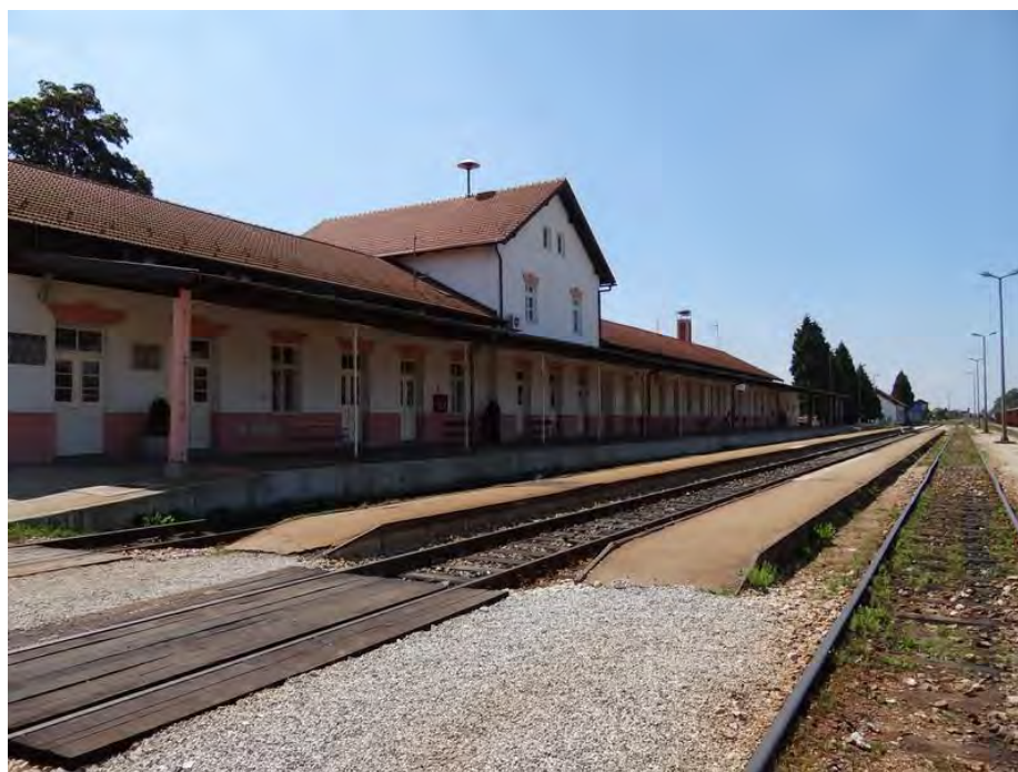
Slika 16.36. Željeznički kolodvor Čakovec
