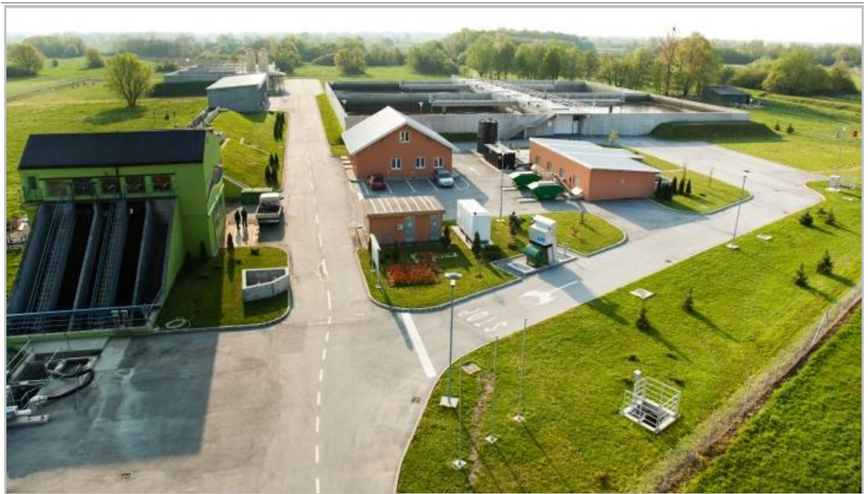
Slika 2-4. Postojeće postrojenje za pročišćavanje otpadnih voda (UPOV)
