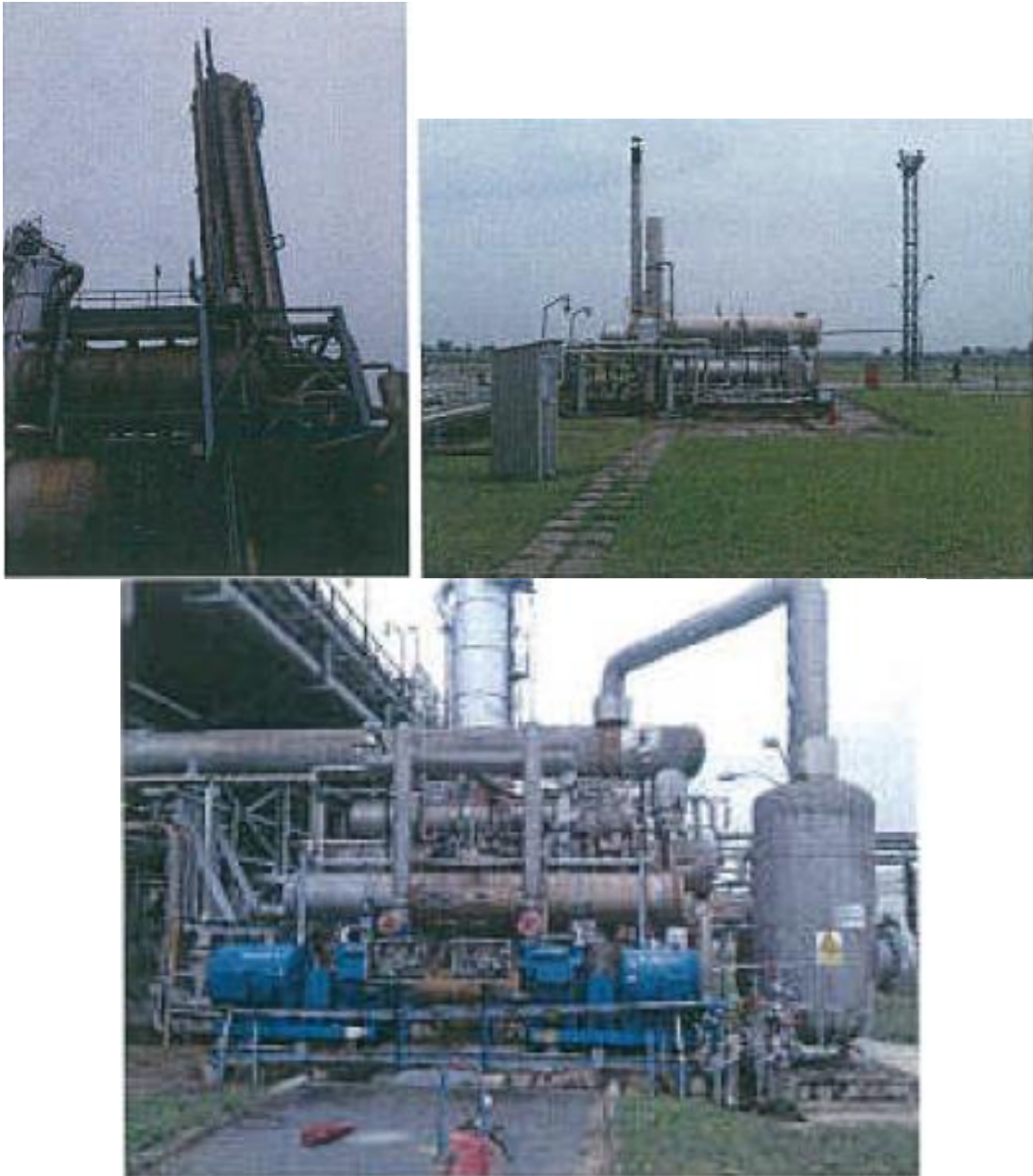
Slika 4.2.6. Striper kolona t-2202 (a), Dehidracija plina (b) i Shtal-rashladna jedinica (c)
