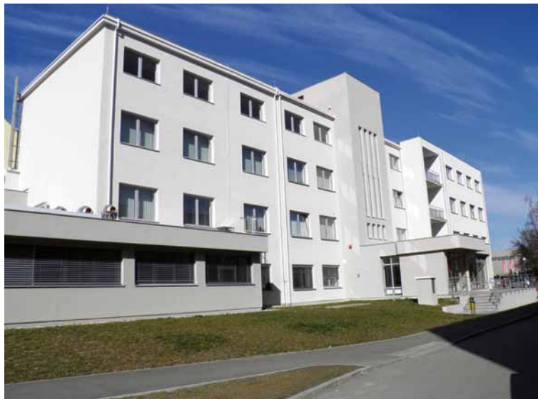
Nova zgrada Zavoda za javno zdravstvo Koprivničko-križevačke županije
