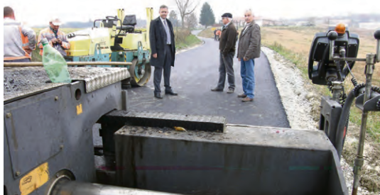
Asfaltiranje dionice Belanovo selo - Rasinja
