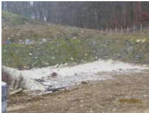
Slika 3.: Trenutno stanje na lokaciji zbrinjavanja azbestnog otpada, „Ivančino brdo“ Izvor: Terenski obilazak lokacije odlagališta „Ivančino brdo“, Odsjek za zaštitu okoliša i prirode Upravnog odjela za prostorno uređenje, gradnju i zaštitu okoliša KKŽ, prosinac, 2011.god.
