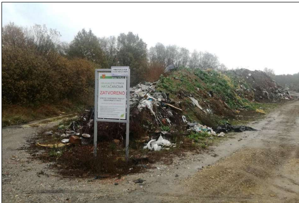
Slika 2.1.-2. Pogled na ulazni dio područja odlagališta
