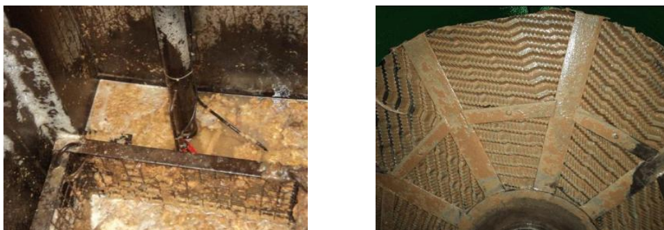
Slika 3.4. Prihvatna komora sa zaštitnom mrežicom (lijevo) i polipropilenske saće s kolonijama bakterija (desno)
