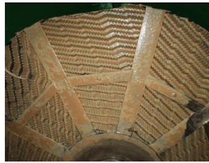
Slika 3.4. Prihvatna komora sa zaštitnom mrežicom i polipropilenske saće s kolonijama bakterija
