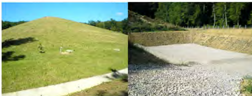
Slika 9. Odlagalište otpada "Ivančino brdo" nakon izvršene sanacije
