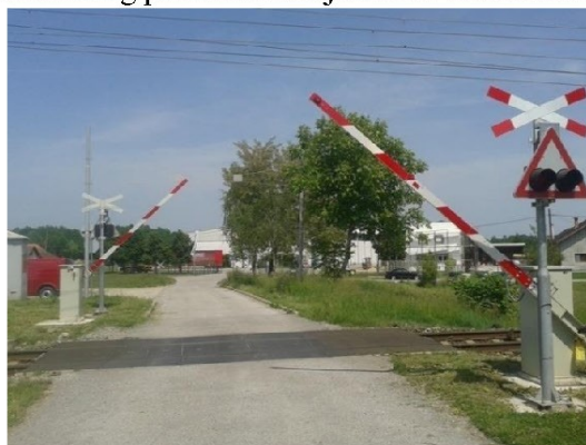
Opremljenost željezničko-cestovnog prijelaza zvučnom i svjetlosnom signalizacijom te polubranicama
