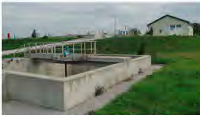
Slika 7 Uređaj za pročišćavanje otpadnih voda
